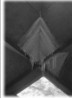
Cobertura do Prédio da FAU-USP
