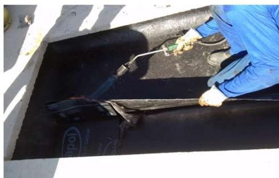
**FIGURA 7-** Aplicação da manta asfáltica. (Fonte: os autores, 2016)
