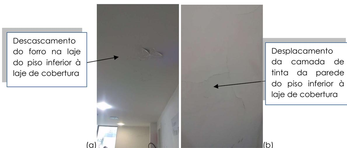
FIGURA 15 a e b-Patologias nos revestimentos. (Fonte: os autores, 2016)
