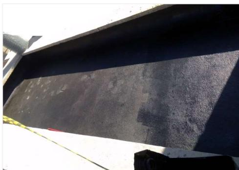
**FIGURA 6-** Regularização e preparação do substrato. (Fonte: os autores ,2016)
