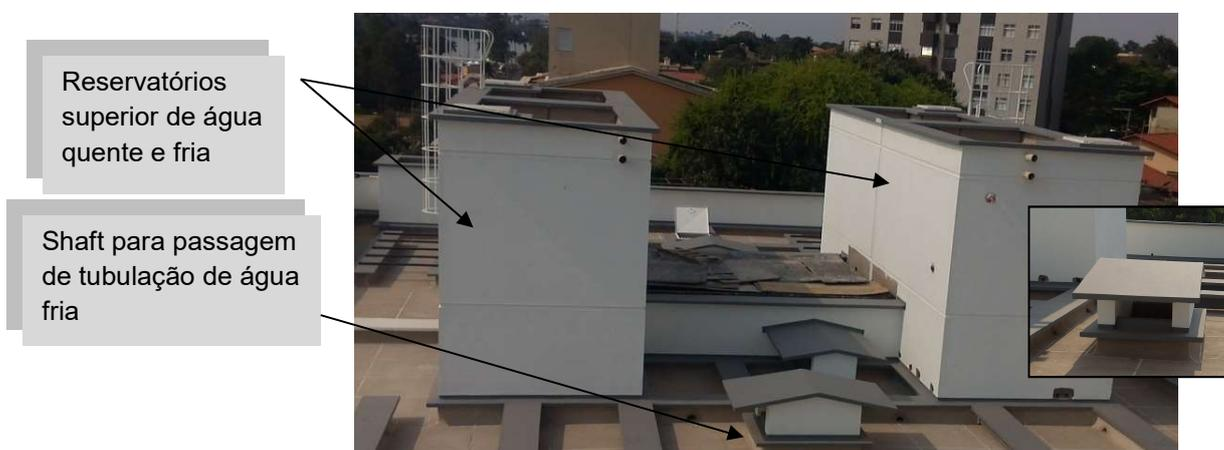
**FIGURA 5** – Detalhamento do sistema de instalação hidráulica. (Fonte: os autores, 2016)
