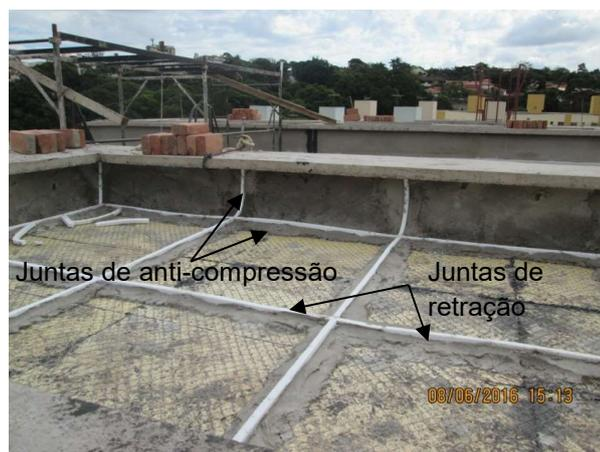
**Figura 10** - Proteção mecânica com juntas de retração e anti-compressão.
