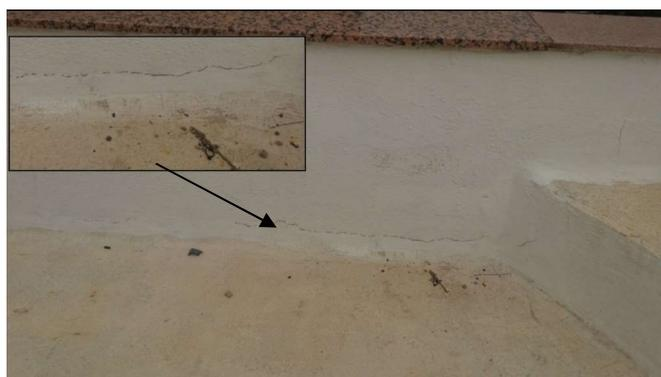
**Figura 20** - Abertura no encontro da platibanda com a laje. (Fonte: os autores, 2016)
