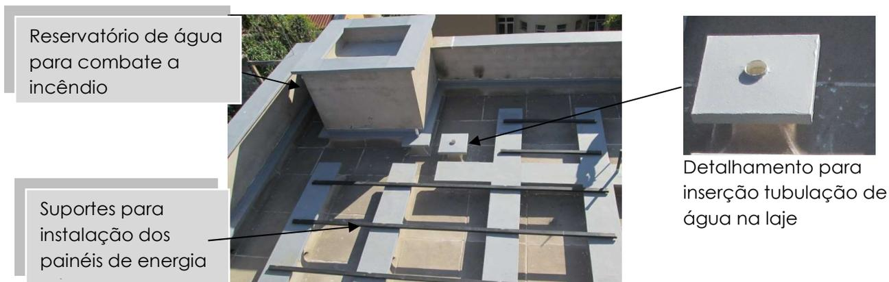
**FIGURA 4** - Detalhamentos: suportes para instalação dos painéis de energia solar sistema de prevenção e combate ao incêndio. Fonte: RESENDE, 2016 (Adaptado)
