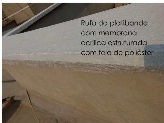
**FIGURA 13-** Emulsão acrílica sobre rufos da platibanda. (Fonte: os autores, 2016)
