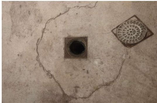
**Figura 16-** Fissuras nas proximidades do ralo (Fonte: os autores, 2016)
