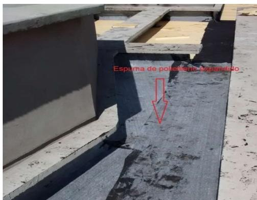
**Figura 8** - Aplicação da espuma de polietileno expandido. (Fonte: RESENDE, 2016, Adaptado)
