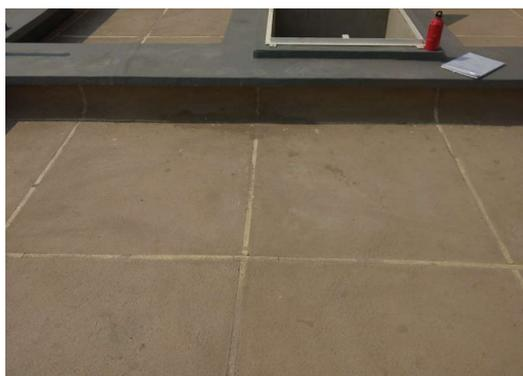
**FIGURA 11**- Proteção mecânica finalizada.
