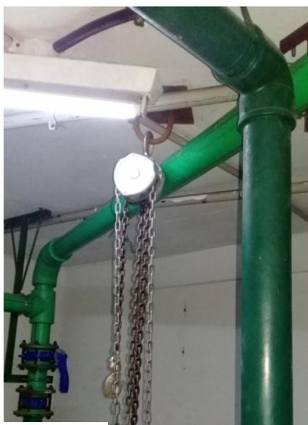
Imagem 11 – Fixação da talha na laje de teto sobre o vão de acesso a cisterna
