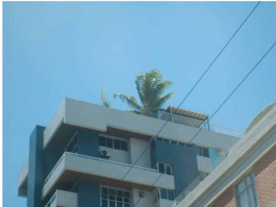
Figura 11- Desafio de impermeabilização em floreira com vegetação de grande porte - acervo do autor.
