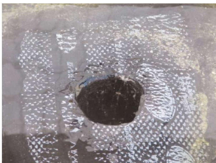
Figura 6 - Acúmulo de água em entorno de ralo - acervo do autor.
