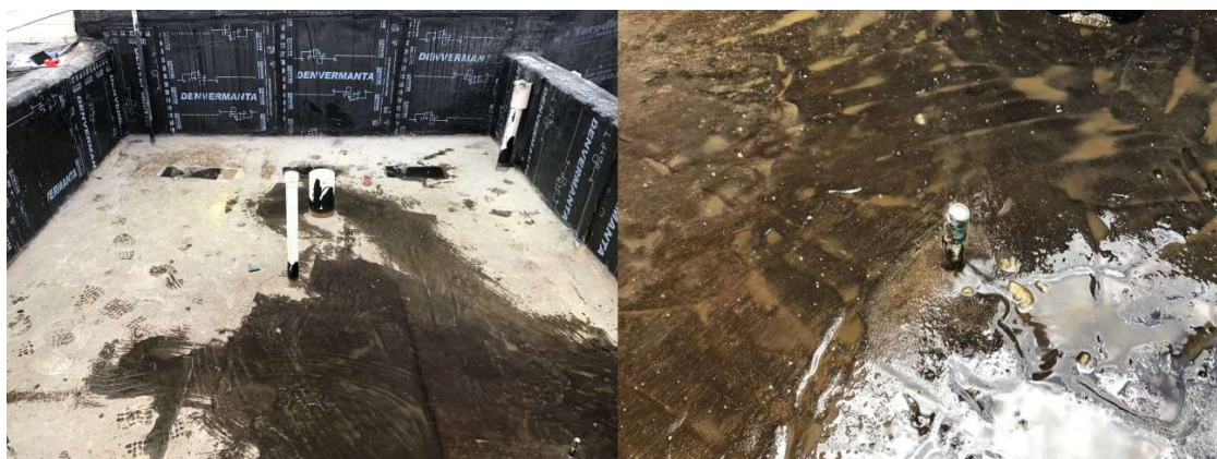
Figura 15: Visão da Área 03 após o teste de estanqueidade
