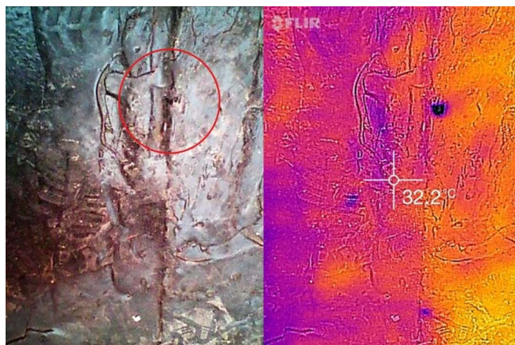
Figura 9: Infiltração no rodapé próximo ao ralo (I1)
