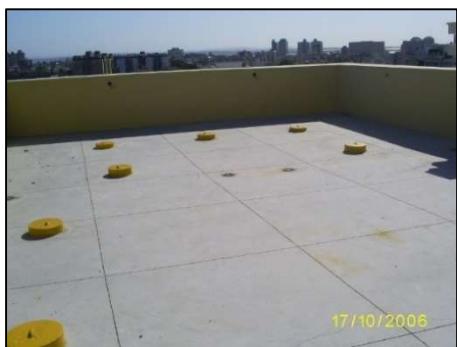
Figura 9.9 – Solução adequada executada na obra.
