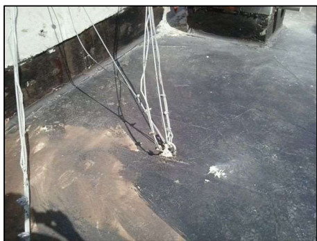
Figura 9.1 – Grampo saliente no piso. Local com impermeação em andamento.
