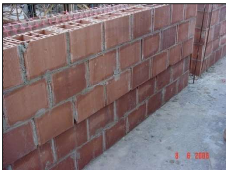
Figura 3.5 – Solução adequada executada na obra.
