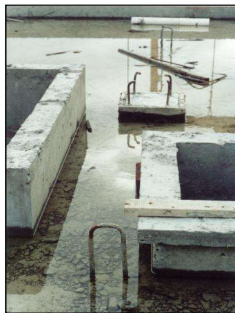
Figura 2.1 – Solução adequada executada na obra.
