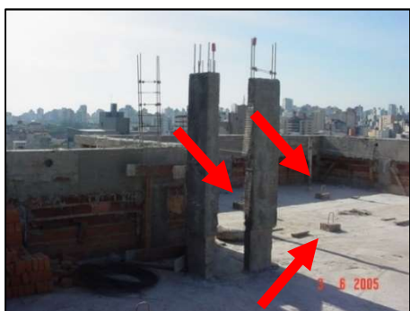
Figura 9.7 – Solução adequada executada na obra. Grampos com base solidária à laje.
