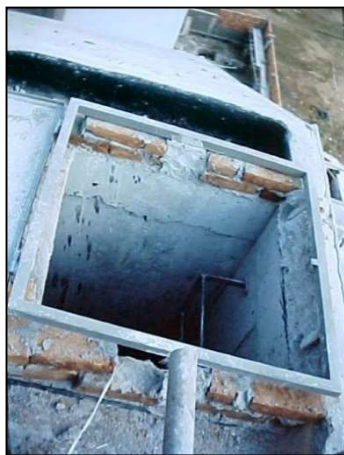
Figura 2.1 – Situação desfavorável executada na obra.
