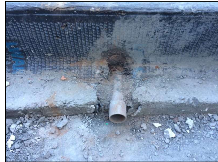
Figura 12.6 – Impermeabilização perfurada para a passagem de tubulação.
