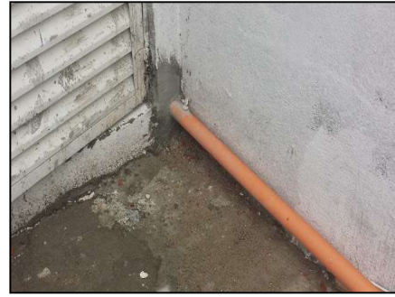
Figura 12.4 – Impermeabilização perfurada para a passagem de tubulação.
