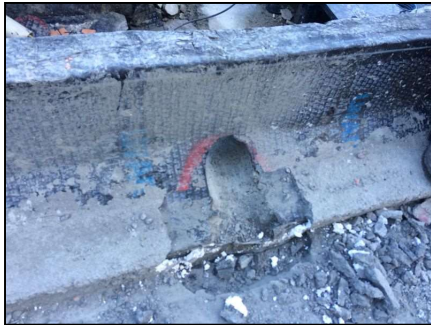
Figura 12.5 – Impermeabilização perfurada para a passagem de tubulação.
