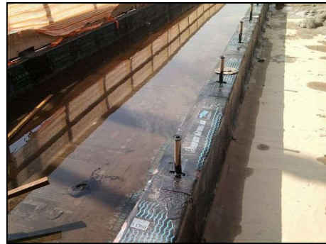
Figura 5.4 – Solução adequada executada na obra. Bases para a fixação dos montantes do guarda-corpo, com interferência com a impermeabilização já resolvida previamente.
