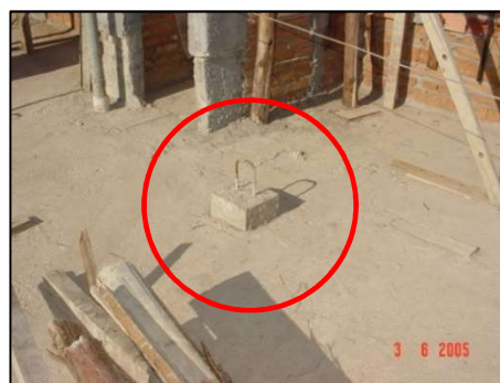
Figura 9.8 – Solução adequada executada na obra. Grampos com base solidária à laje.
