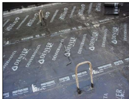
Figura 9.2 – Grampo saliente no piso. Local com impermeabilização aplicada.
