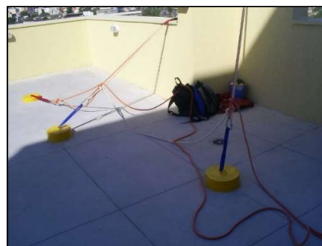
Figura 9.10 – Solução adequada executada na obra.
