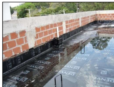
Figura 3.6 – Resultado da solução adequada executada na obra para a platibanda da Figura 3.5.
