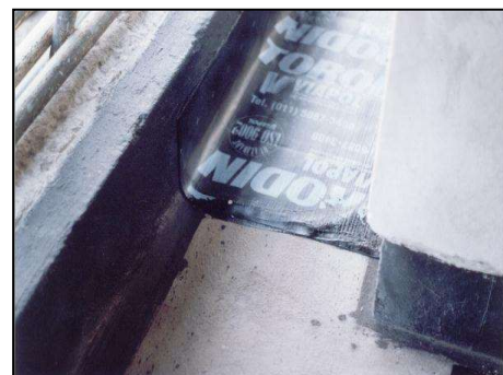
Figura 7.4 – Solução adequada executada na obra. Aplicação da impermeabilização no plano horizontal e no vertical, passando sobre o canto arredondado para essa finalidade de transição entre os planos.
