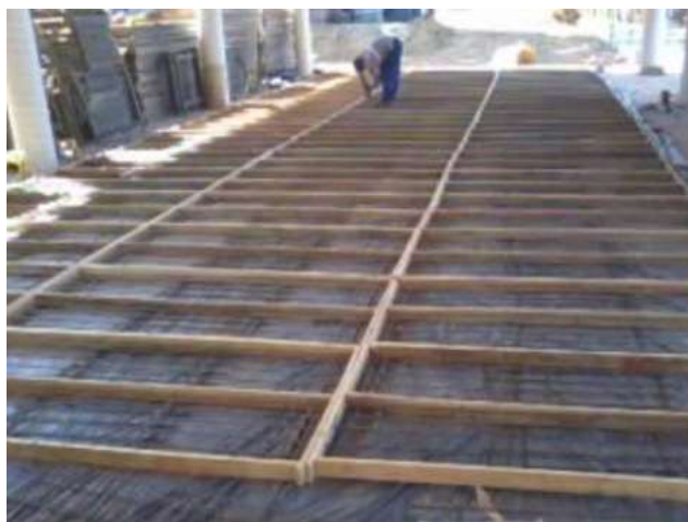
Figura 2.3 – Formas preparadas para receber o concreto para moldagem das lajes.
