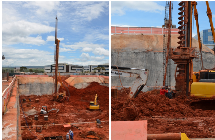
Figura 1 – Execução da fundação com solução em hélice contínua.
