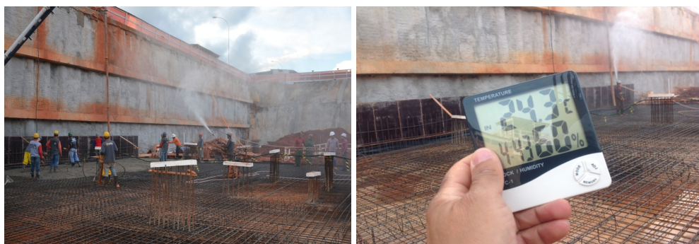
Figura 7 - Aspersão de água para controle de umidade do microclima
