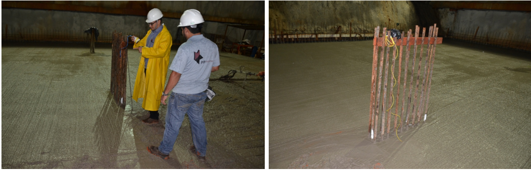
Figura 9 - Instalação do TERMOPAR para controle da temperatura de cura
