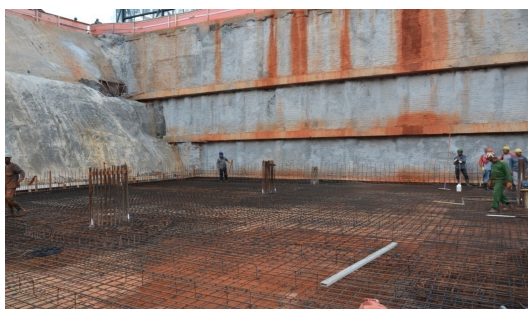
Figura 4 – Execução de laje de concreto magro
