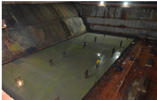
Figura 11 - Cura submersa com 5 cm de colchão de água sobre a laje
