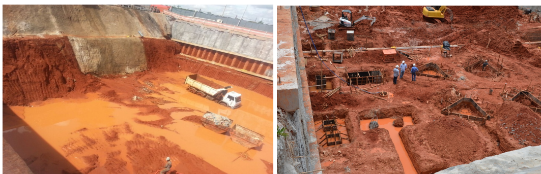
Figura 2 – Rebaixamento do lençol freático
