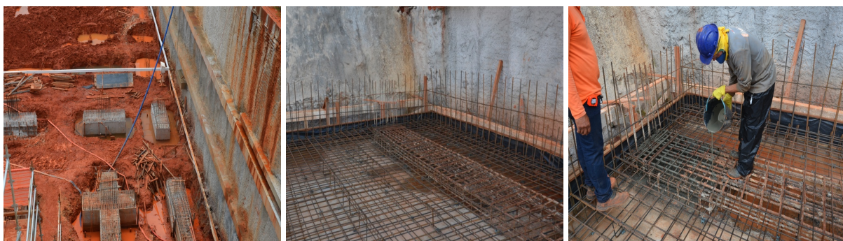
Figura 3 – (a) Execução dos blocos; (b) Armaduras trespessadas da laje de subpressão e do bloco; (c) Execução de ponte de aderência com aditivo autocicatrizante
