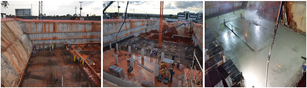
Figura 5 – (a) Concretagem do primeiro trecho; (b) Concretagem do segundo trecho; (c) Concretagem do terceiro trecho
