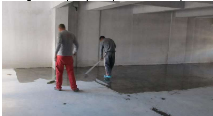
Figura 12 – Aplicação de primer à base de epóxi
