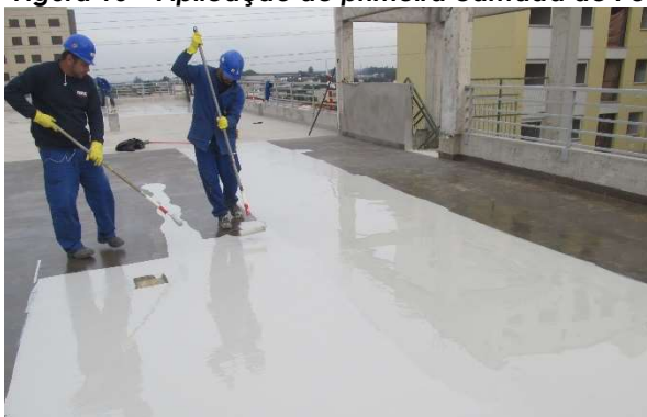
Figura 13 – Aplicação de primeira camada de PU
