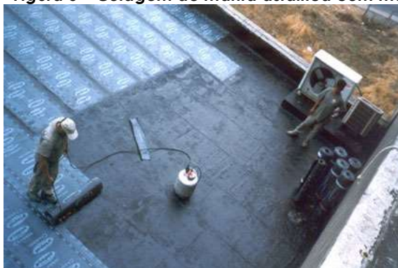
Figura 5 – Colagem de manta asfáltica com maçarico
