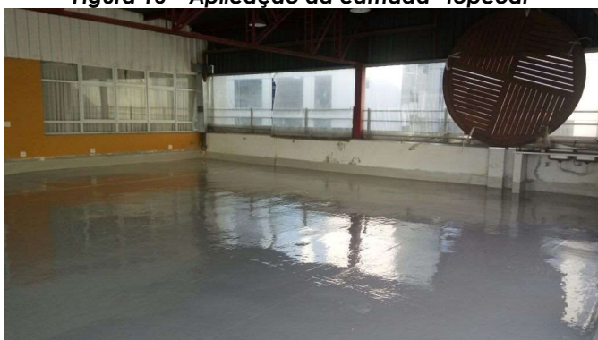
Figura 16 – Aplicação da camada “topcoat”
