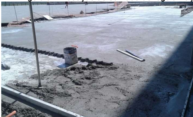
Figura 3 – Execução de camada de regularização
