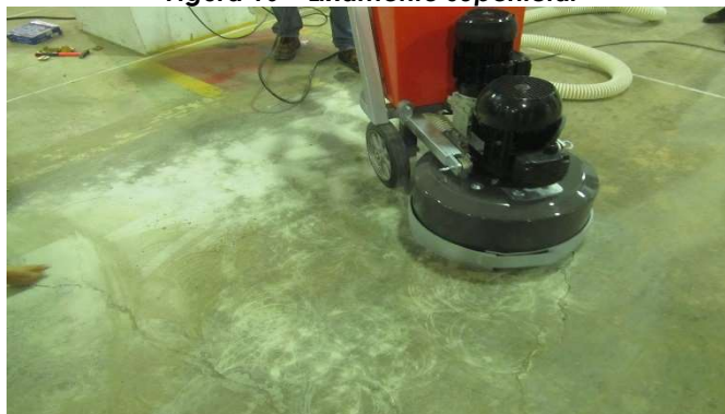
Figura 10 – Lixamento superficial
