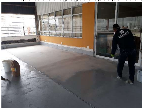
Figura 14 – Aspersão de agregado após período de “gel”
