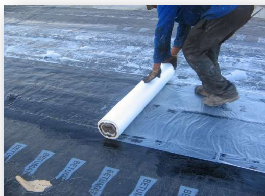
Figura 6 – Instalação de camada separadora
