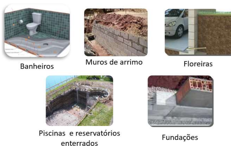
Figura 1. Utilização de argamassas poliméricas
