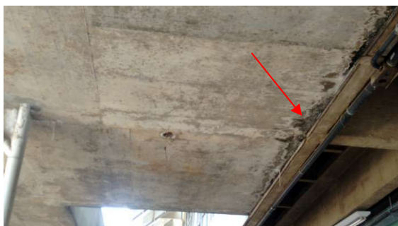
Figura 1- Junta de dilatação estrutural em concreto aparente. (Fonte: a autora, 2017)
