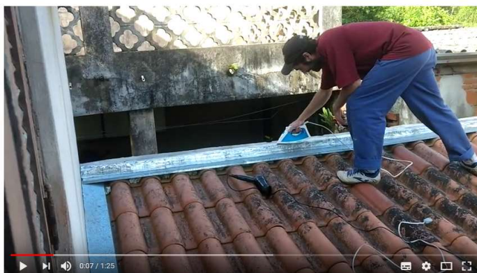
Como colocar manta asfáltica com ferro de passar roupa.
