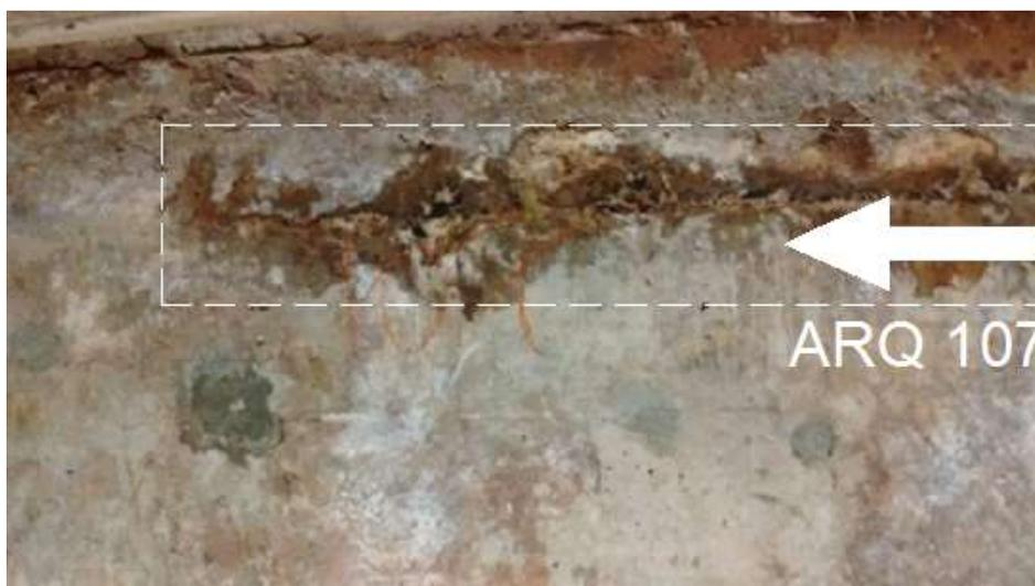
Figura 13 – Parede da casa de força com presença de fissura úmida
