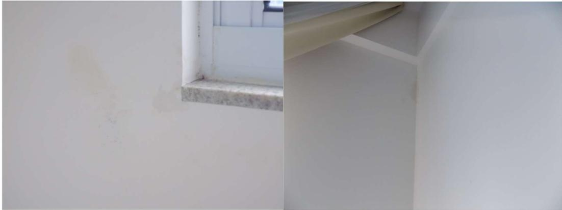
Figura 6 – Manifestações patológicas por infiltração em janela e parede
