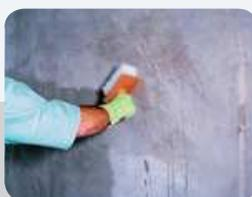
Antes de iniciar a aplicação, o substrato deverá apresentar-se limpo. Não pode haver qualquer parte solta ou desagregada, nata de cimento, óleos e desmoldantes. Para promover a limpeza necessária, faça uma lavagem com escova de aço e água ou jato d'água de alta pressão. Ninhos e falhas de concretagem deverão ser tratados previamente com argamassa de cimento e areia (traço 1:3). Umedeça o local de aplicação com auxílio da trincha ou brocha sem encharcar a superfície.
