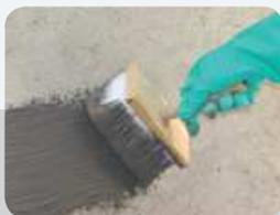
Com auxílio de uma trincha, aplique as demãos em sentido cruzado, em camadas uniformes. Siga a orientação do fabricante do produto em relação à quantidade de demãos. Quando necessário, arredonde os cantos. É importante que o produto seja aplicado de maneira uniforme.
