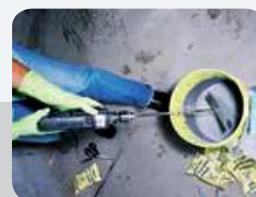
Despeje a resina acrílica (A) em um balde limpo. Adicione o cimento polimérico (B) aos poucos e misture até obter uma massa homogênea. Respeite sempre o tempo de mistura indicado no produto. Quando utilizado processo mecânico, a recomendação usual é misturar por 3 minutos. Já quando utilizado processo manual, a mistura deve ser feita por 5 minutos. Não se esqueça de que em hipótese alguma deve ser adicionada água na mistura.
