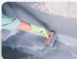
Para reforçar os cantos, aplique uma tela de poliéster no local após a 2ª demão. Em seguida aplique a 3ª demão do produto até a tela ficar completamente coberta. As demãos devem ser sempre cruzadas. Após cura do produto pelo período indicado pelo fabricante do material, realize o teste de estanqueidade e execute a proteção mecânica.
