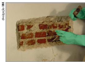
Foto 1 - Primeiro remove-se todo o revestimento.
