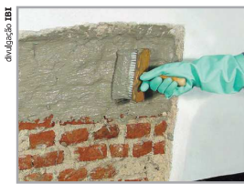
Foto 2 - Só então, aplica-se o impermeabilizante.
